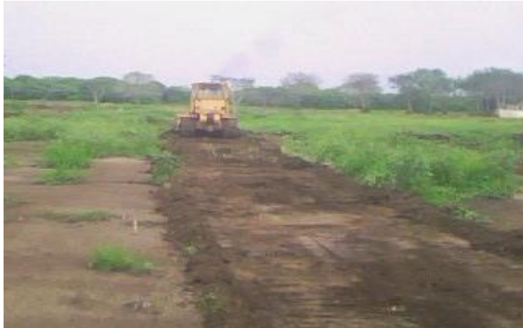
Fotografía 11 desmonte con bulldozer D6
