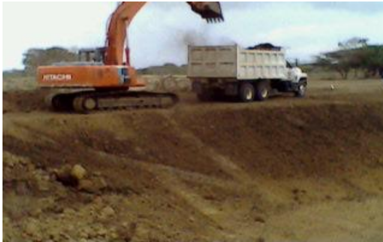
Fotografía 8 Conformación de Talud con Hitachi 330
