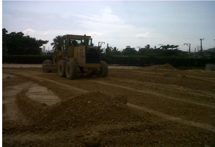
Fotografía 19 Cerezo de terrazas con Motoniveladora
