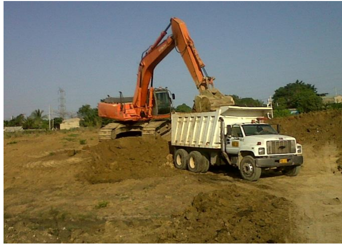
Fotografía 10 Cargue en obra con Hitachi 330
