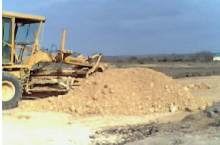
Fotografía 17 Perfilacion de Material con Motoniveladora
