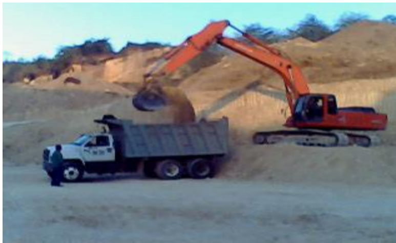
Fotografía 9 Cargue en Cantera con Hitachi 330
