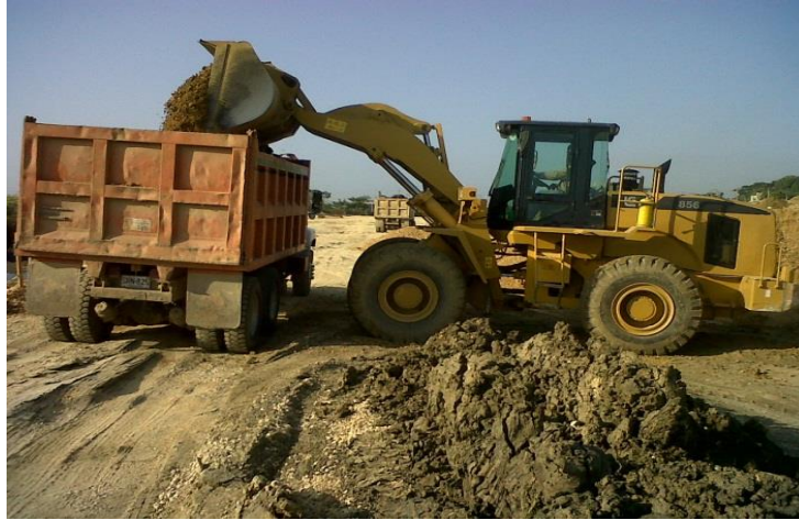
Fotografía 14 Cargue de Volquetas con Cargador
