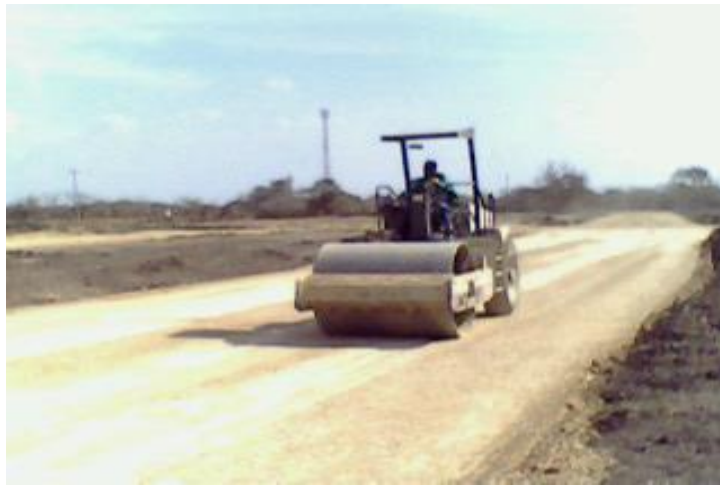
Fotografía 21 Compactación de bases con vibro de 10 t
