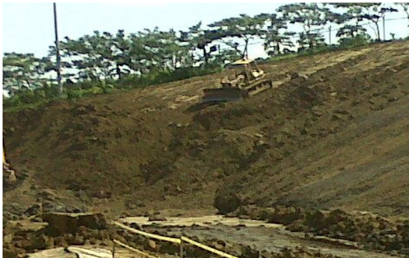
Fotografía 12 Descapote con bulldozer D6
