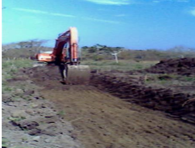
Fotografía 7 Excavación de caja para conformación de vías
