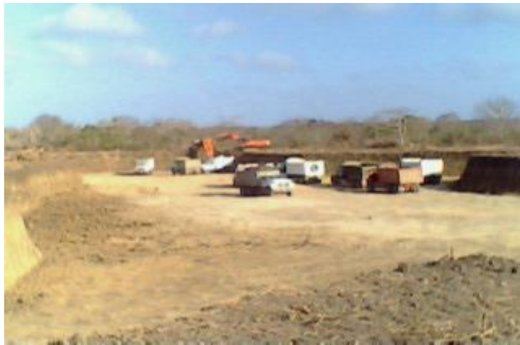
Fotografía 16 Excavación de lagos artificiales con Hitachi 330
