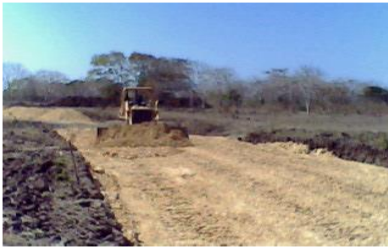
Fotografía 13 Extendida de Material de Relleno con bulldozer D6
