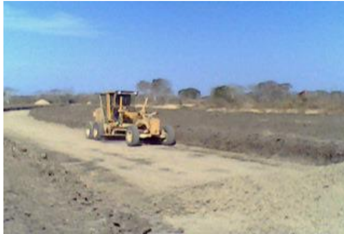
Fotografía 18 cereo de vías con Motoniveladora
