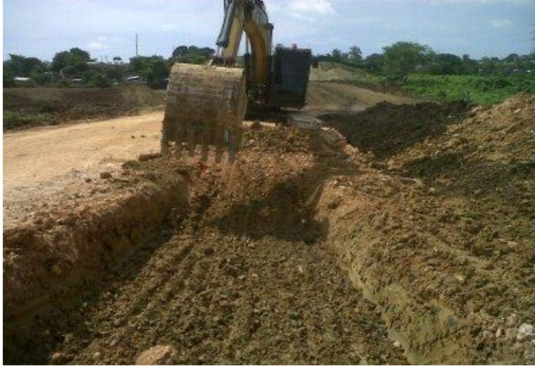
Fotografía 15 Excavación de zanja con Caterpillar 200
