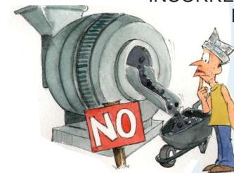
El hormigón debe salir de la betonera con la trabajabilidad requerida. Si esto no sucede, debe devolverse el hormigón a la betonera y agregar agua revolviendo nuevamente. Controle y ajuste la cantidad de agua en las primeras amasadas de acuerdo con la trabajabilidad especificada. NUNCA agregue agua al hormigón que está en la carretilla.
