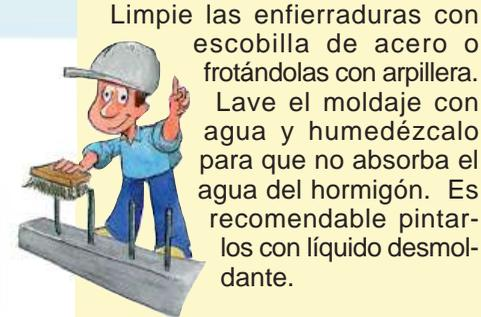
Limpie las enfierraduras con escobilla de acero o frotándolas con arpillera. Lave el moldaje con agua y humedézcalo para que no absorba el agua del hormigón. Es recomendable pintarlos con líquido desmoldante.
