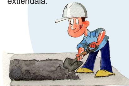
**3.** Revuelva el cemento y la arena hasta obtener perfecta uniformidad. Extienda la mezcla en la cancha. Repita la operación dos veces.
