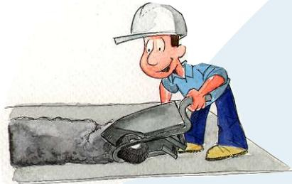
**1.** Disponga de una cancha de hormigón pobre para la preparación del hormigón. Mida la arena previamente corregida por su esponjamiento, en carretillas dosificadoras o con un cajón cubicado. Váciela en la cancha y extiéndala.
