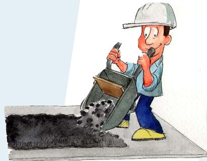
**4.** Vacie el ripio, medido en carretilla dosificadora o cajón cubicado, sobre la mezcla de arena y cemento.
