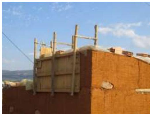
**Figura 7.** Detalle del tapial en la construcción de vivienda en tapias pisada, Barichara - Santander
