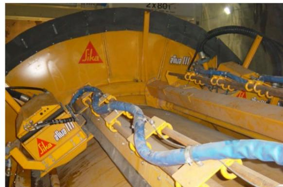
Estabilización del túnel con hormigón proyectado vía húmeda, aplicado desde la sección de la TBM.
