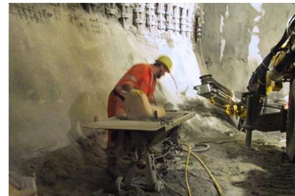
Estabilización de la excavación temporal con mortero proyectado vía seca.
