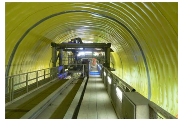
Sistemas de impermeabilización durable, aplicado después del hormigón proyectado y antes del revestimiento de hormigón del segmento interior
