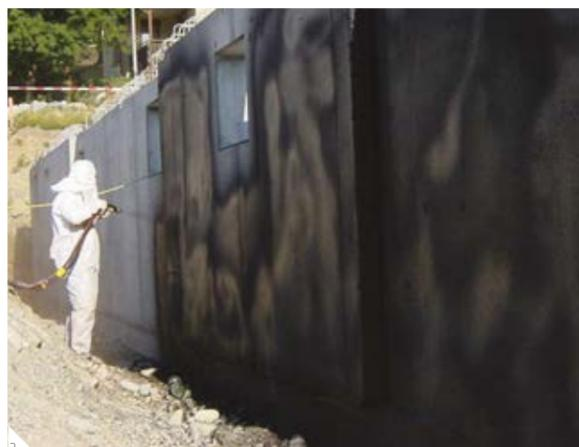
Membranas y recubrimientos asfálticos
