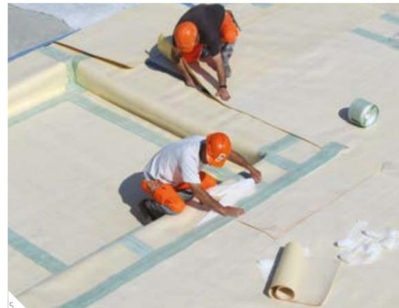
Membranas completamente adheridas
