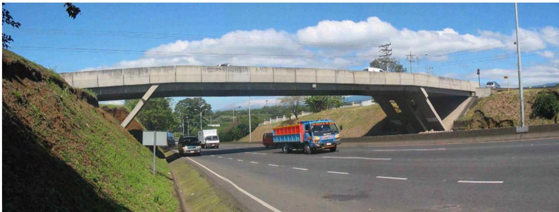
Fig. 4.25: Solución del puente con concreto preesforzado con miembros esbeltos y forma de arco. Con esta configuración se evitan los empujes del terreno y mejora la apariencia.
