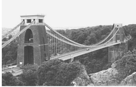
Fig. 3.17: Ejemplo de contraste de torres masivas y tablero esbelto. Puente de Clifton, Inglaterra, 1864, de Isambard Kingdom Brunel.
