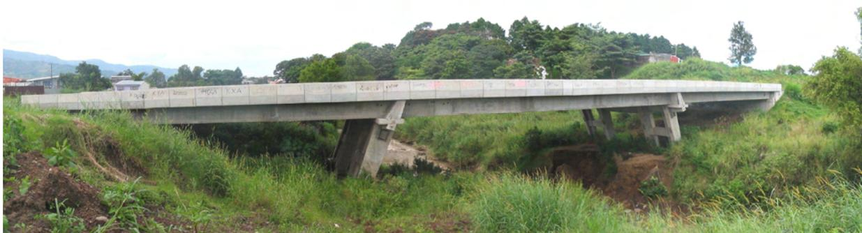
Fig. 4.27: Puente de concreto preesforzado, carretera radial a Desamparados, con 98 m de largo.
