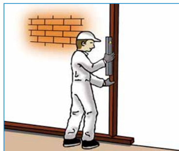
Figs. 8 y 9. Se aplica la pasta de yeso sobre las miras y se reciben las miras sobre la pared. Se aprietan las miras y se comprueba la verticalidad de las mismas con el nivel de burbuja
